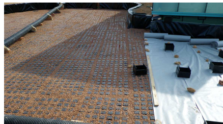
El elemento de drenaje y retención de agua Floradrain® FD 60 fue relleno con Zincolit® Plus y cubierto con el filtro sistema SF.
